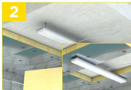
Pour un luminaire, abaissez le luminaire, reportez l'emplacement des tiges filetées sur le panneau et glissez le panneau entre la dalle et le luminaire. Dans le cas d'un néon, placez les 2 extrémités avant de placer la partie centrale.
