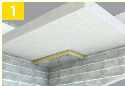
Positionnez le premier Panodal dans un angle, perpendiculairement aux poutrelles hourdis. Dans le cas d'une dalle, pas de contrainte particulière.
