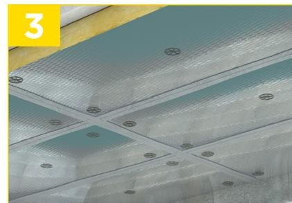
Finissez par jointoyer les panneaux en appliquant l'adhésif Panodal Tape pour une finition parfaite.
