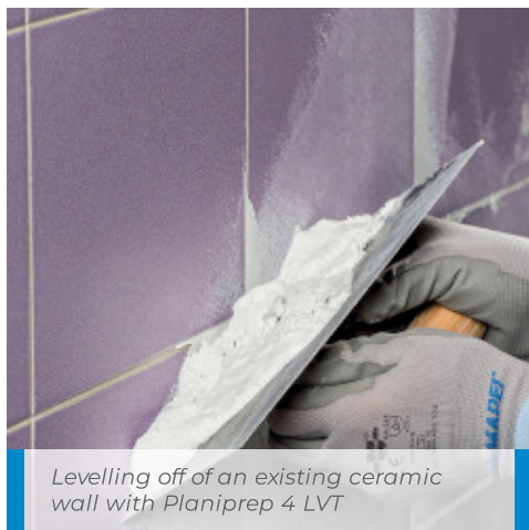
pose de LVT à envers adhésif sur ancien carrelage ragréé avec Planiprep 4 LVT
