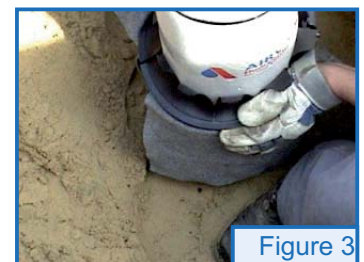
Mise en place de la garniture de protection.
