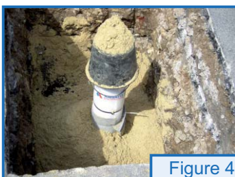
Remblayage de la tranchée.
