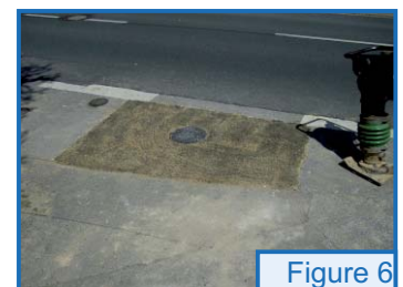
Finition de la chaussée.
