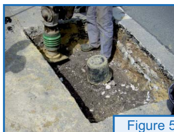
Compactage du matériau de remplissage.
