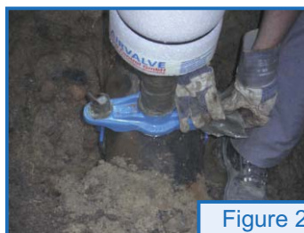
Application de la protection anti-corrosion de la connexion.
