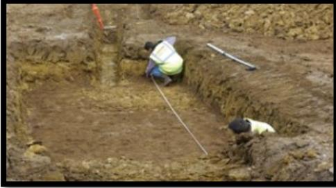
Préparer le sol récepteur en le mettant à niveau et retirer tout objet pointu du fond de la fouille.
