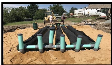
Insérer les piézomètres dans les trous du bas des adaptateurs 2 trous sur une longueur d'environ 10 cm.
