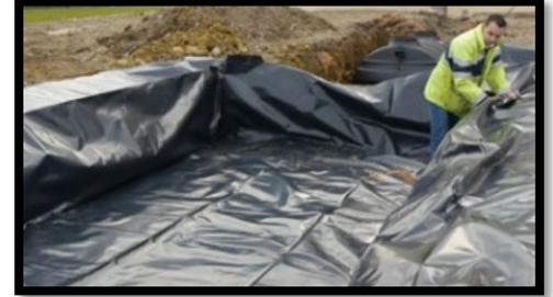
Déployer et positionner votre film PE 400 µm réel sur l'ensemble de la surface.
