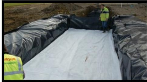
Placer le géotextile anticontaminant afin de le protéger des perforations dues au gravier lavé.
