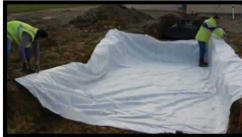
Placer le géotextile antipoinçonnant dans le fond et bord de la fouille.
