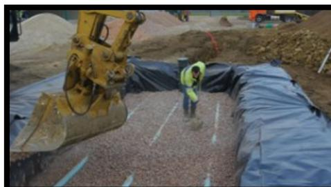
Combler de 10 cm de gravier stable à l'eau de diamètre 10/40 mm.
