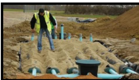
Recouvrir de sable filtrant sur une hauteur de 10 cm sur les conduites Enviro))Septic.
