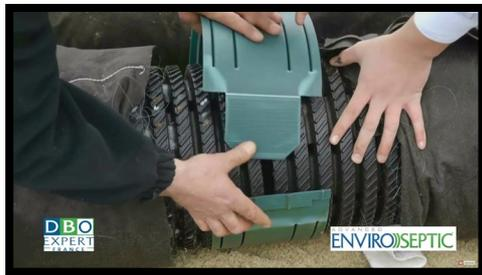
Installer les manchons sur les conduites en plaçant les rainures dans les cavités des conduites.
