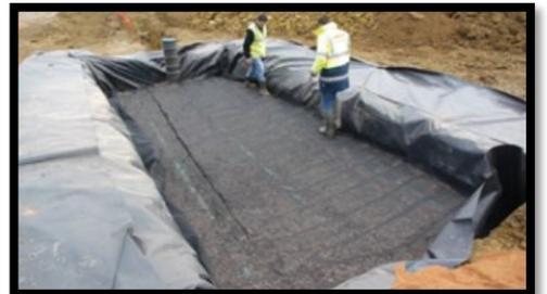
Recouvrir le gravier avec la grille de filtration (géogrille)
