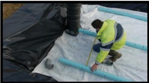
Positionner les rangées de drains (voir plan) ainsi que le regard de collecte. Ce dernier doit être raccordé sur le tuyau d'évacuation.
