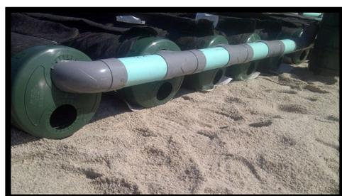
Insérer la colonne de ventilation dans les trous du haut de l'adaptateur 2 trous avec une légère pente de 1% vers les conduites Enviro))Septic pour éviter l'accumulation de condensation.
