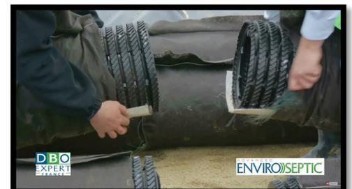
Dégager les membranes géotextile des extrémités des conduites à relier.
