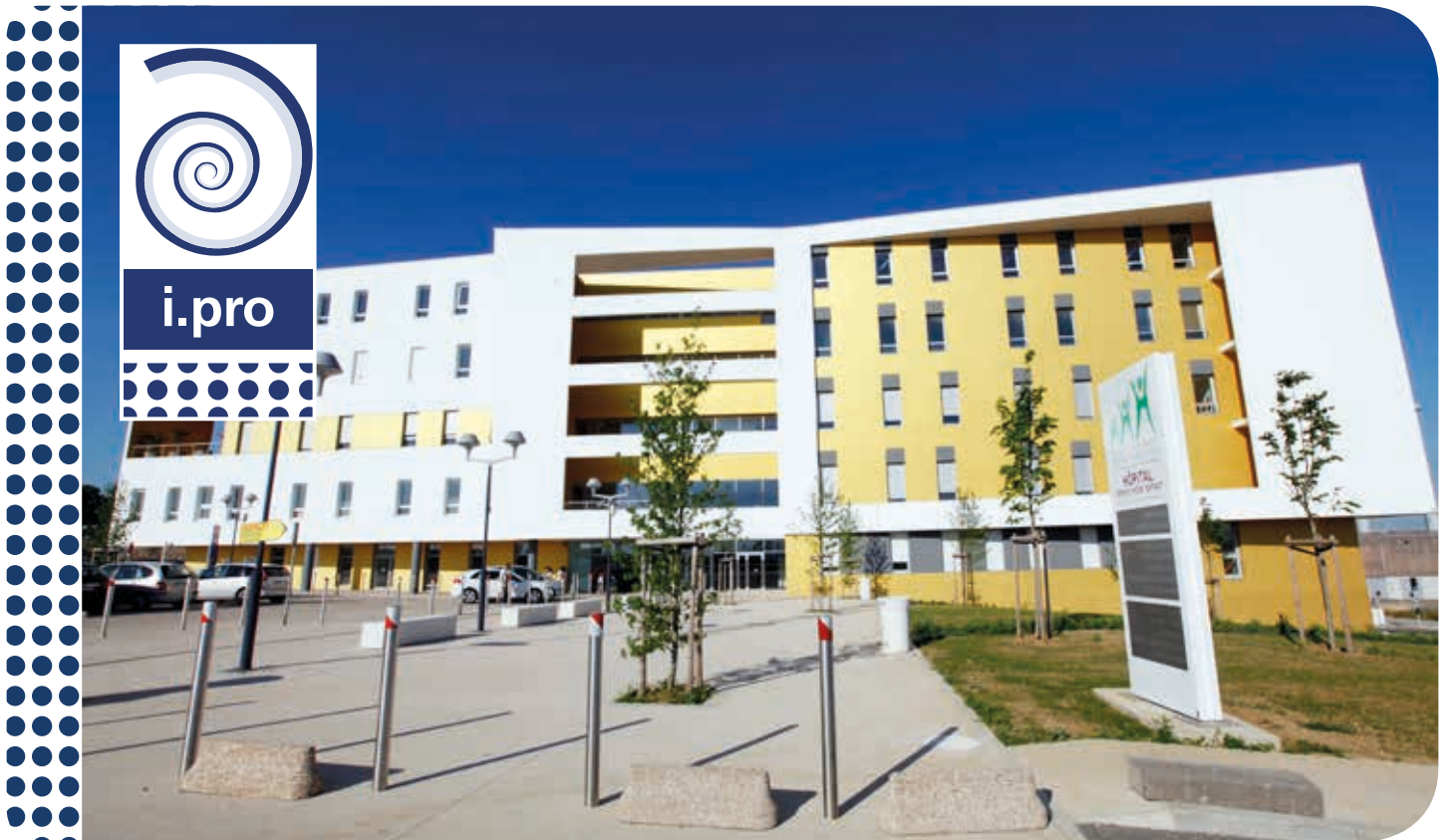
Hôpital de Metz-Thionville à Ars-Laquenexy (57) - Architecte : AART FARAH Architectes associés.
