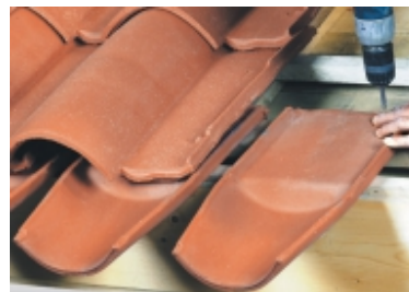
Les tuiles sont tranchées biaisées parallèlement à l'axe de la noue
