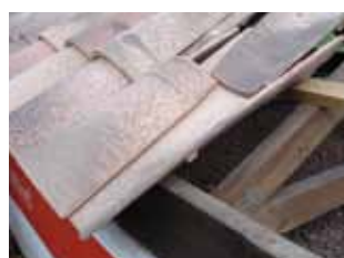
6 Avec un pureau longitudinal de 36 cm au 2 e rang, la tuile coupée de départ est en pose alignée à l'égout.
