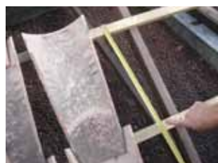
1 Les courants se posent longitudinalement entre 36 et 42 cm (pureau variable: 36 cm < pureau longitudinal < 42 cm) (1) .
