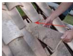
3 La pose des couverts, très simple, s'effectue en 3 étapes successives: L'arrière du couvert vient toucher le devant des courants de la rangée supérieure.
