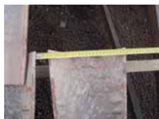
2 En latéral, les courants se posent avec un pureau allant de 24 à 26 cm.
