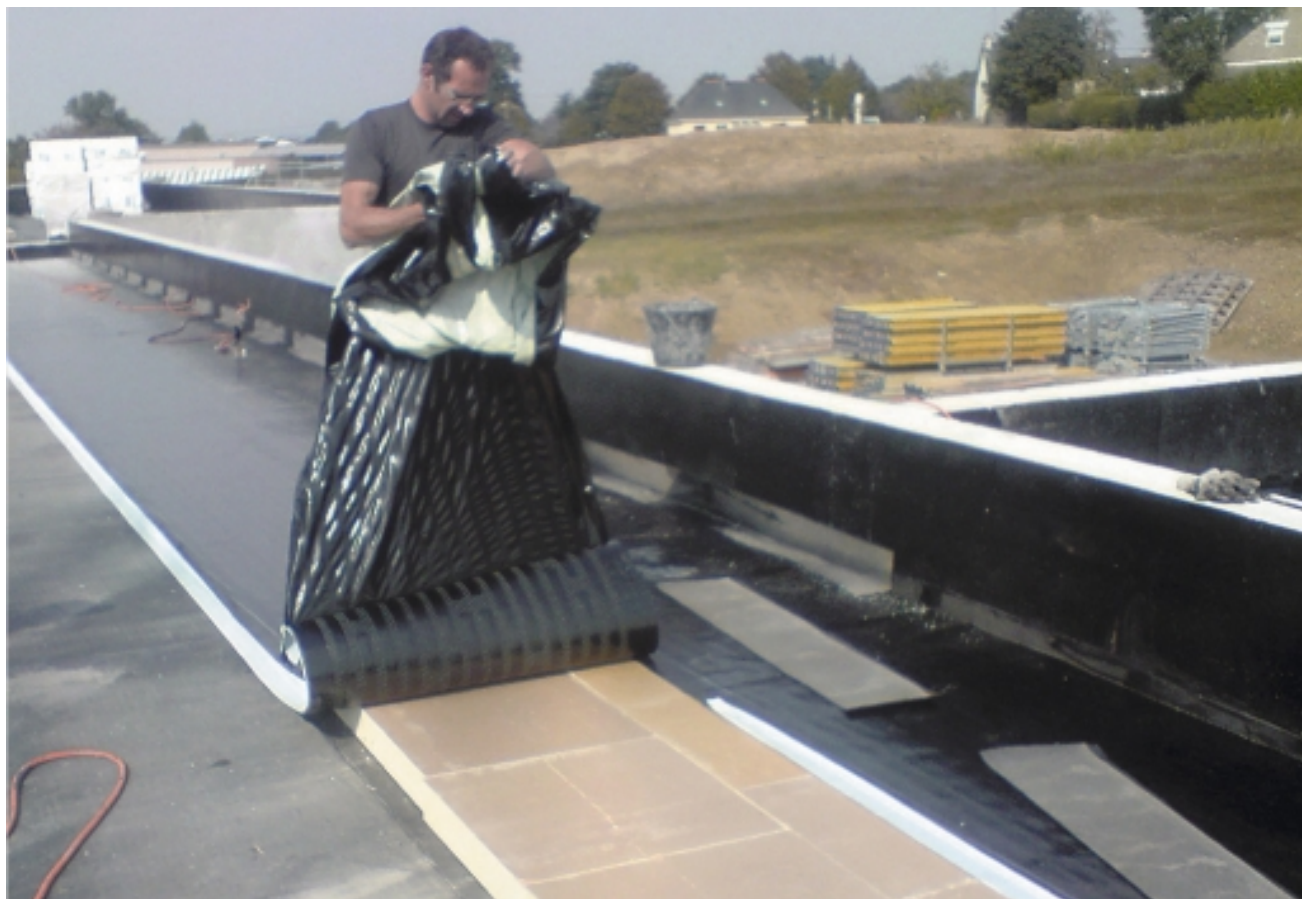
Revêtement d'étanchéité semi-indépendant par autoadhésivité sur Knauf Thane MuTTI
