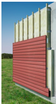
Mise en place d'un pare-pluie
