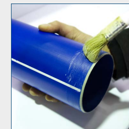
Appliquer le lubrifiant sur l'extrémité du tube et sur le joint du raccord
